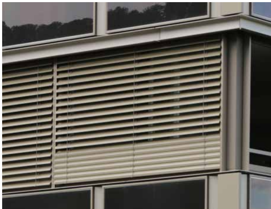
Lamisol® Reflect mit unterschiedlichen Lamellenstellungen in einem Behang (Option).
